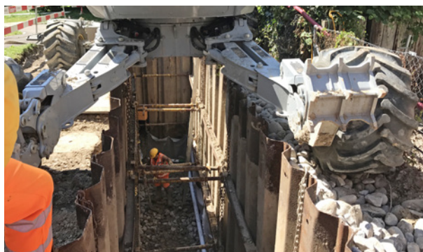
Umfangreiche Spezialtiefbauarbeiten waren beim Bau der Abwasserleitungen des Alters- und Pflegezentrums nötig.
