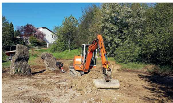
Aushub und Entwässerungsarbeiten beim Spielplatz auf dem Areal des Schulhauses Binzholz.
