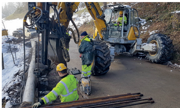
Verankerung von Fertigbetonelementen an der Sanatoriumstrasse.
