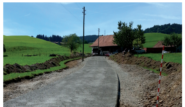
Die Tannereggstrasse wurde in Form einer Betonstrasse erneuert.
