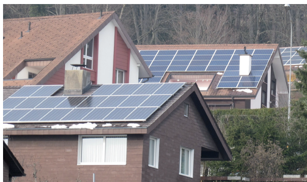
Immer öfter anzutreffen: Hausdächer mit Photovoltaikanlagen produzieren erneuerbare Energie.
