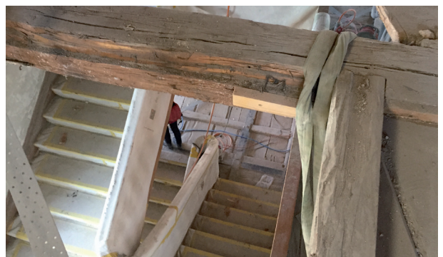
Der Deckendurchbruch war nötig für den Bau einer neuen Stahltrappe ins Dachgeschoss des Gemeindehauses.
