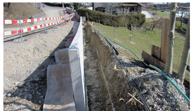
An der Glärnischstrasse wurde zur Stabilisierung des Geländes eine neue verankerte Stützmauer errichtet.
