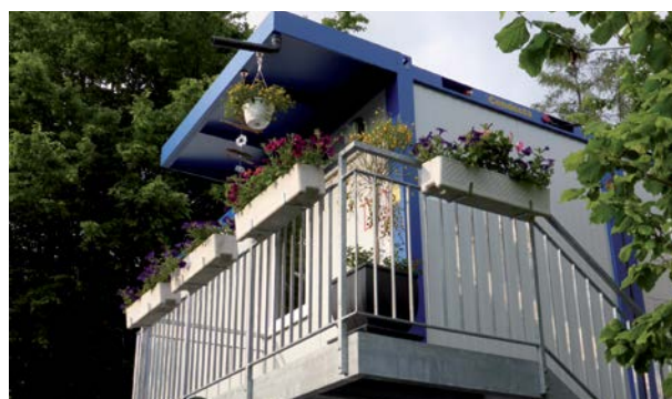
Auch Bürocontainer können mit einer schönen Begrünung gefällig aussehen.
