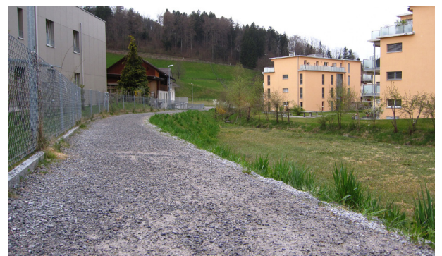
Eisweiherweg: Der neue Fussweg verbindet die Quartiere der Chefstrasse mit der Laupenstrasse.
