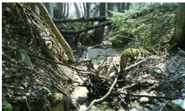
Der Sagenbach vor der Reinigung mit Tot- und Schwemmhölzhäufen.
