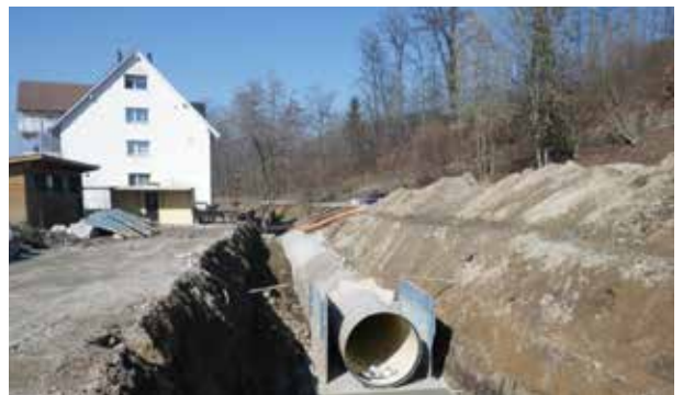
Hochwassersicherheit: Verlegung GFK-Rohr (Glasfaser verstärkter Kunststoff) unter dem Viehprämiierungsplatz.
