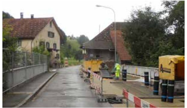
Lochbachbrücke: Alterungsbeständige Polymerbitumen-Dichtungsbahnen werden aufgeflammt.
