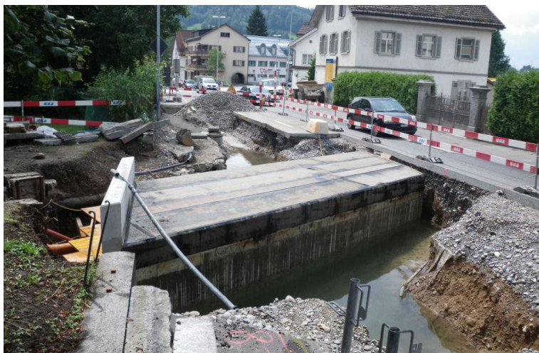
Foto: Schlipfbach Abschnitt C1, die erste Hälfte des Betonkanals ist erstellt und muss aushärten
