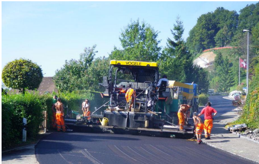
Foto: Dieterswilerstrasse, der Deckbelag wird eingebaut
