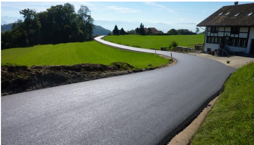
Foto: Tänlerstrasse nach der Sanierung
