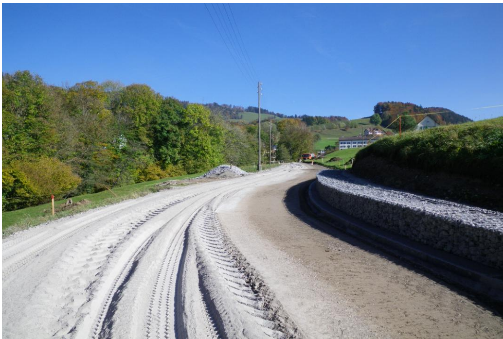
Foto: Diezikonerstrasse, der Strassenoberbau wird mit Zement stabilisiert
