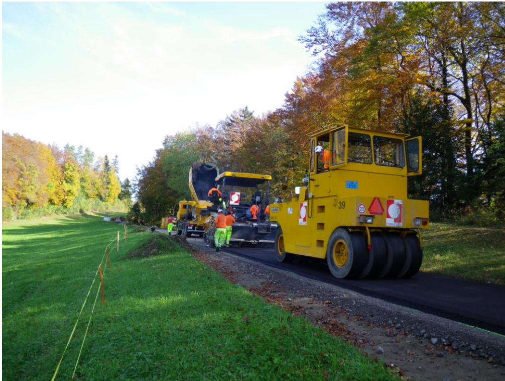
Foto: Belagseinbau Dachseggstrasse
