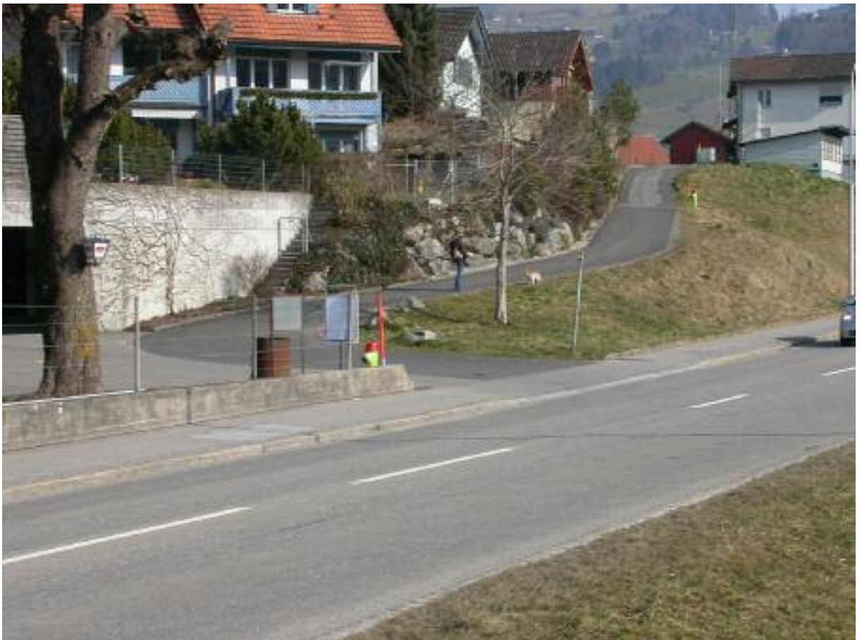
Foto: Geissbühlstrasse mit neuem Deckbelag.
