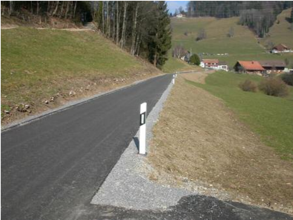
Foto: Chrinnenstrasse, saniert im Kaltrecyclingverfahren.
