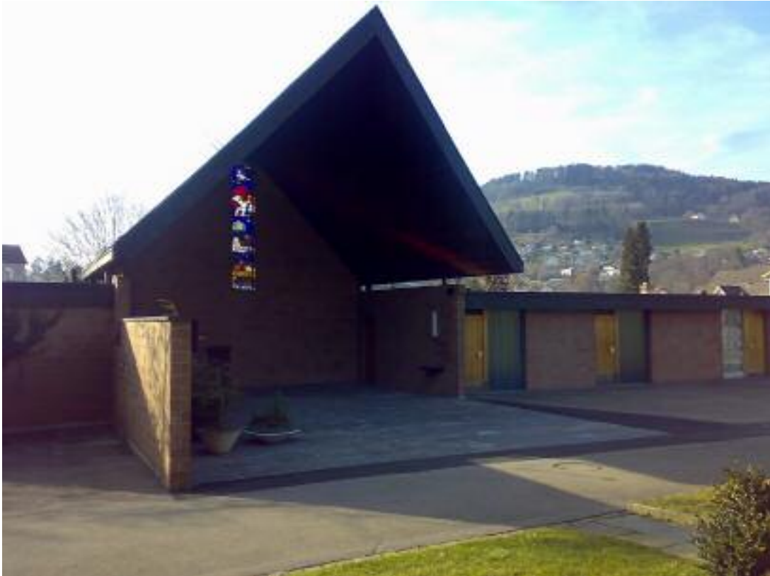
Foto: Neu verlegte Granitplatten bei der Abdankungshalle.
