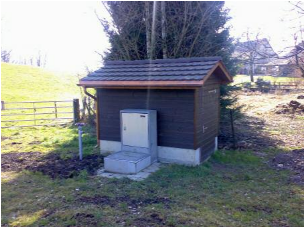
Foto: Pumpenhaus Widenriet
