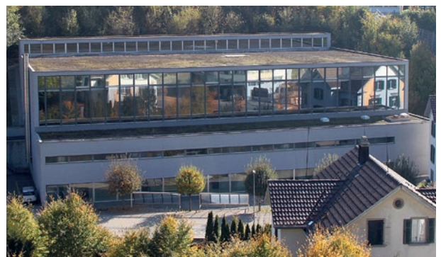
Die bald 20-jährige Sporthalle Elba erhält an der bauprägenden Fensterfront eine Aufstockung.
