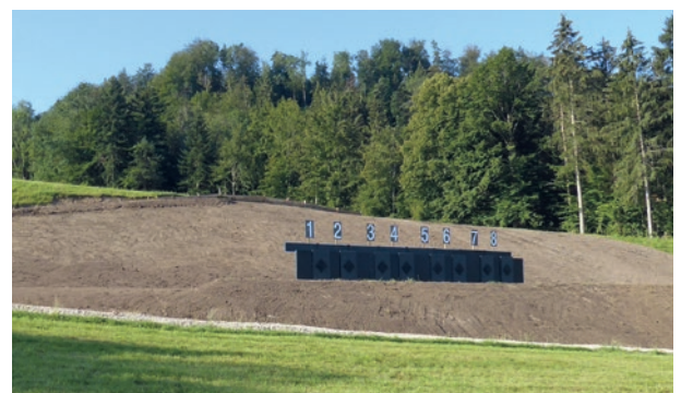
Die Schiessanlage Neuholz nach der Sanierung, mit dem neuen künstlichen Kugelfang.
