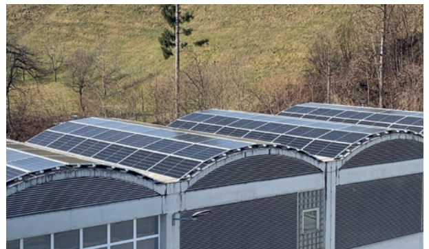
Klärwerk: Auf dem Dach des Filtrationsgebäudes entstand eine der neuen Photovoltaikanlagen in der Gemeinde.
